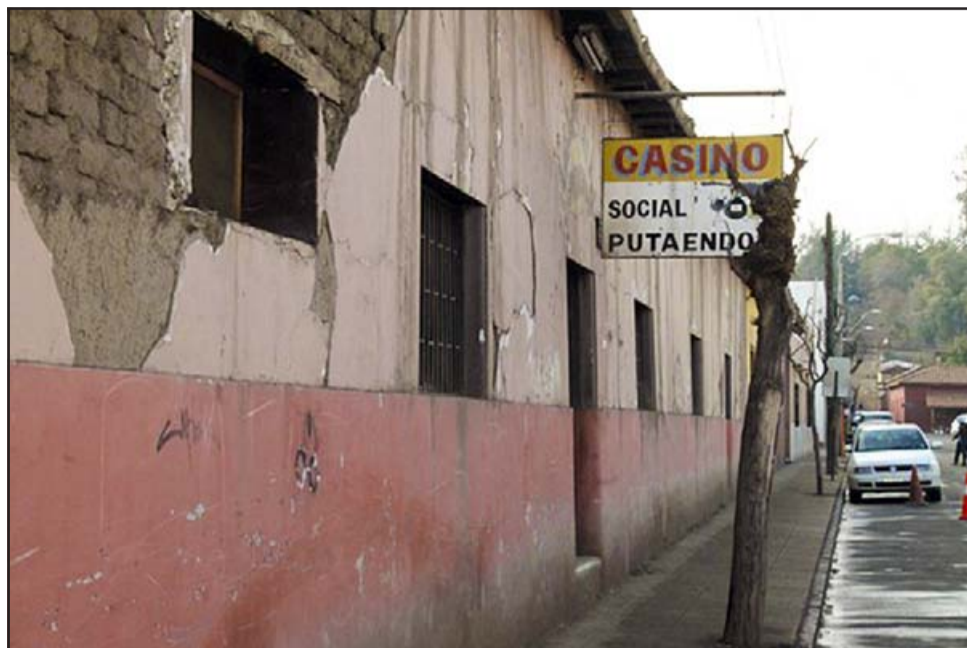
A través del 'Fondo del Patrimonio Cultural', la municipalidad de Putaendo obtuvo $69.852.156 para mejorar preventivamente las actuales instalaciones de la histórica construcción ubicada en calle Camus.
