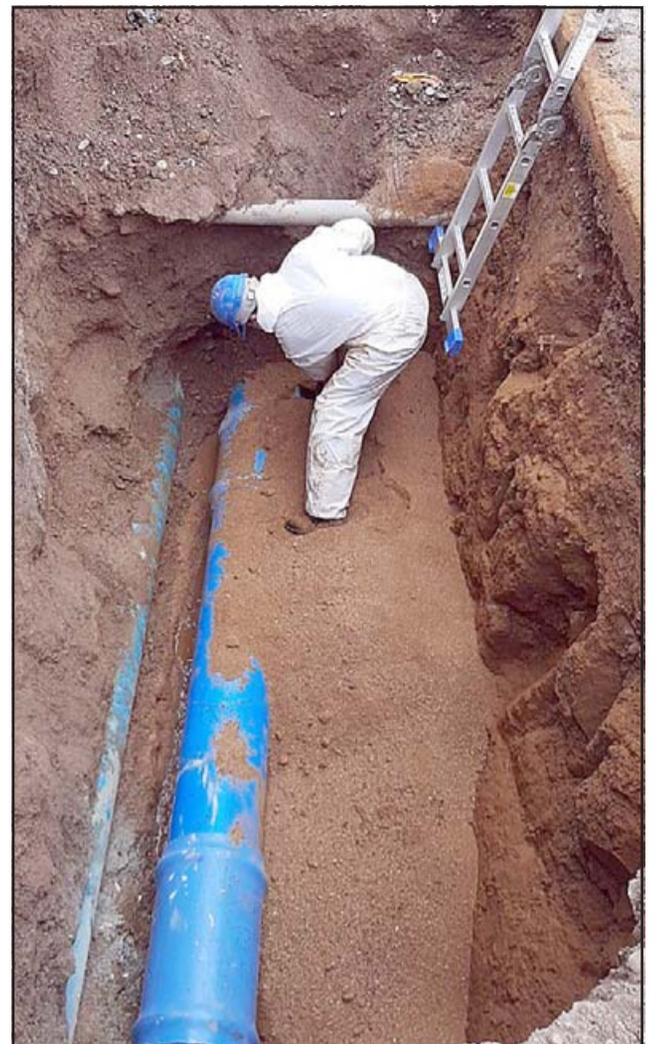
Los trabajos de modernización de la infraestructura sanitaria existente, consideran el recambio de 278 metros de tubería.
