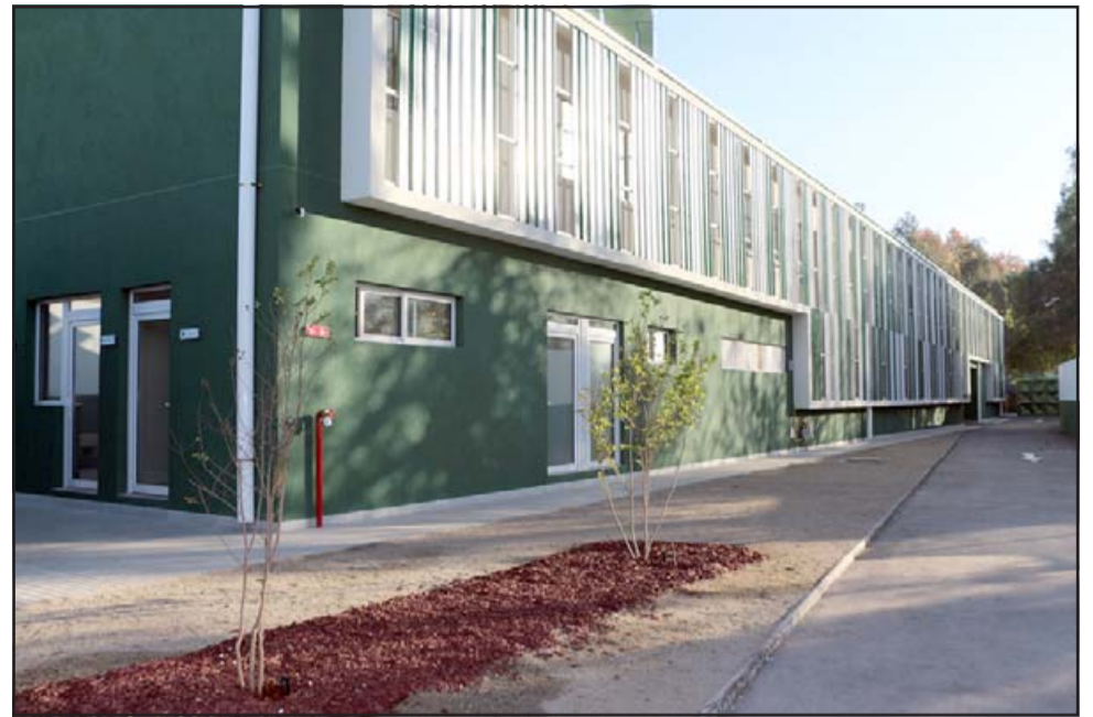
NUEVAS INSTALACIONES. - Los trabajos fueron desarrollados por la Dirección de Arquitectura del MOP con una inversión de $5.000 millones de pesos por parte de Carabineros.
