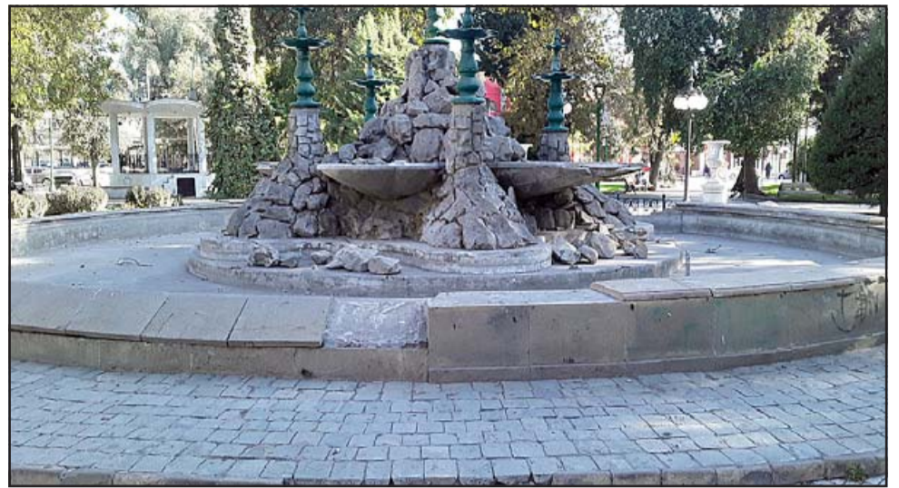
Así luce hoy la pileta de la Plaza de Armas de San Felipe, pidiendo a gritos una mejora.
