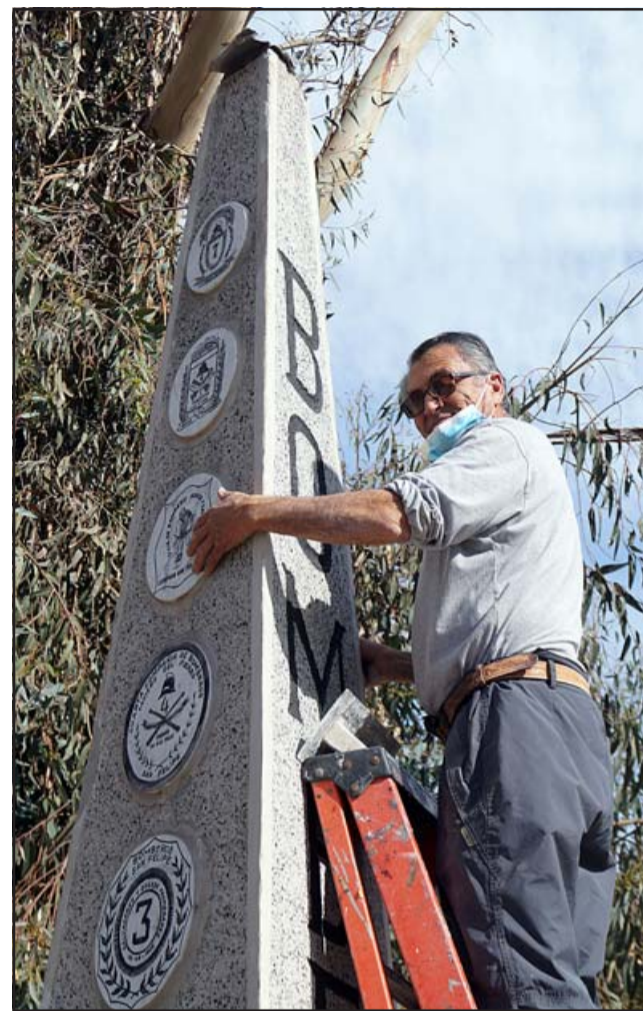
REPARANDO DAÑOS. - Don José Rozas , de una empresa externa, trabajaba este martes en la reparación del dañado obelisco de la Segunda Compañía de Bomberos.
