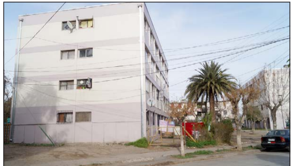
COMO NUEVOS.- Todas las paredes fueron reparadas por completo, y lucen como nuevas gracias a este trabajo de mejoramiento.
