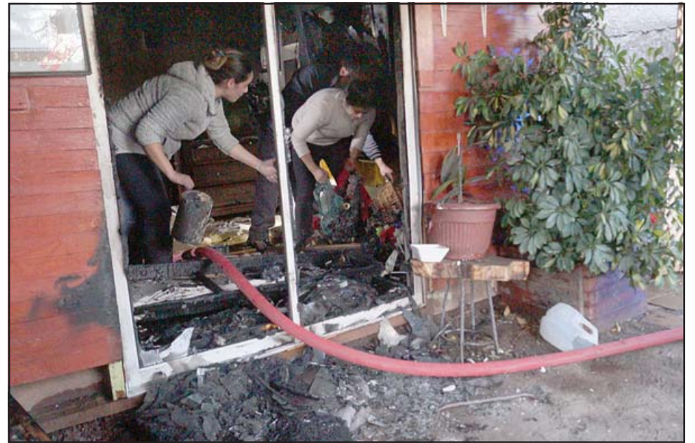
PÉRDIDAS MILLONARIAS. - El ventanal principal de esta vivienda colapsó, quemándose cortinas, muebles, alfombras y electrodomésticos de sus moradores.
