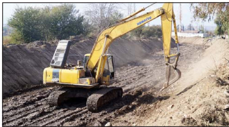
A TODA MÁQUINA. - Las cámaras de Diario El Trabajo registraron este martes la maquinaria que ya trabaja en la limpieza del estero Quilpué.
