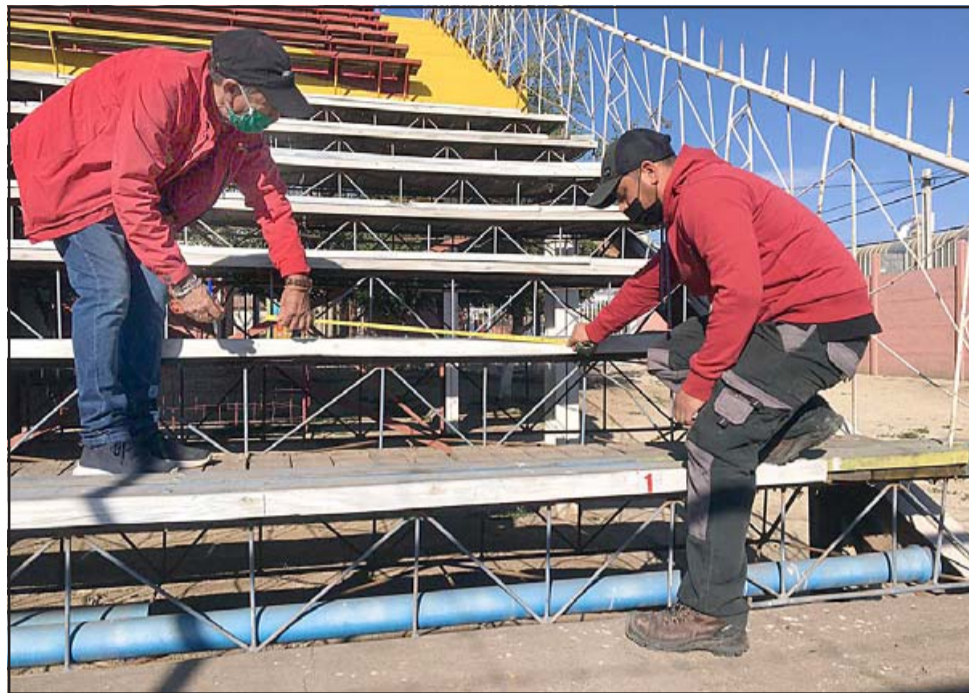
Empleados municipales enumeran las graderías y reparan daños en las mismas.
