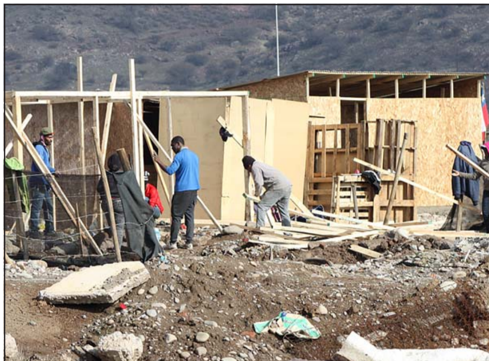
El campamento Yevide surgió en julio de 2020, apoyado por la Iglesia Católica, en una labor humanitaria que, no obstante, afectó considerablemente la calidad de vida de los habitantes del sector.
