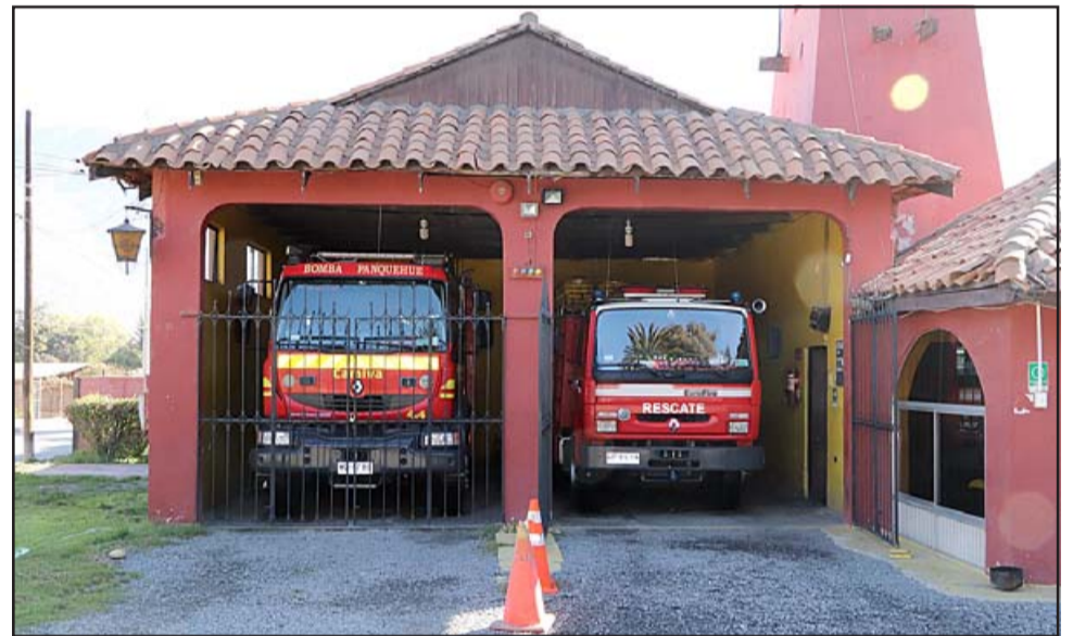
Estas son las actuales dependencias de Bomberos de Panquehue, se espera que pronto se construya un mejorado cuartel.
