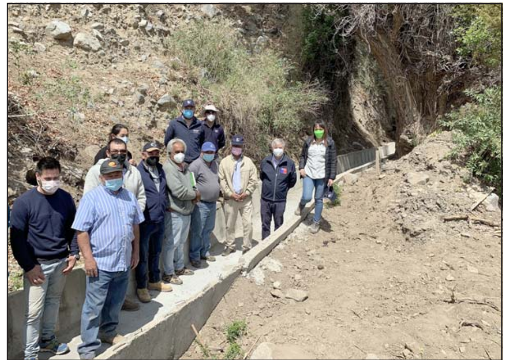
Los trabajos plantean limpieza, despeje, movimientos de tierra, instalación de nuevas losetas de hormigón para evitar filtraciones y nuevas compuertas para regular el paso del agua. (Foto archivo)
