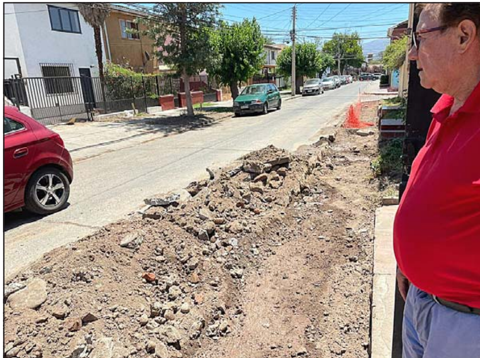
Un vecino observa los trabajos frente a su casa, los cuales están causando bastantes problemas que pudieron evitarse o mitigarse con una adecuada socialización que no se realizó.
