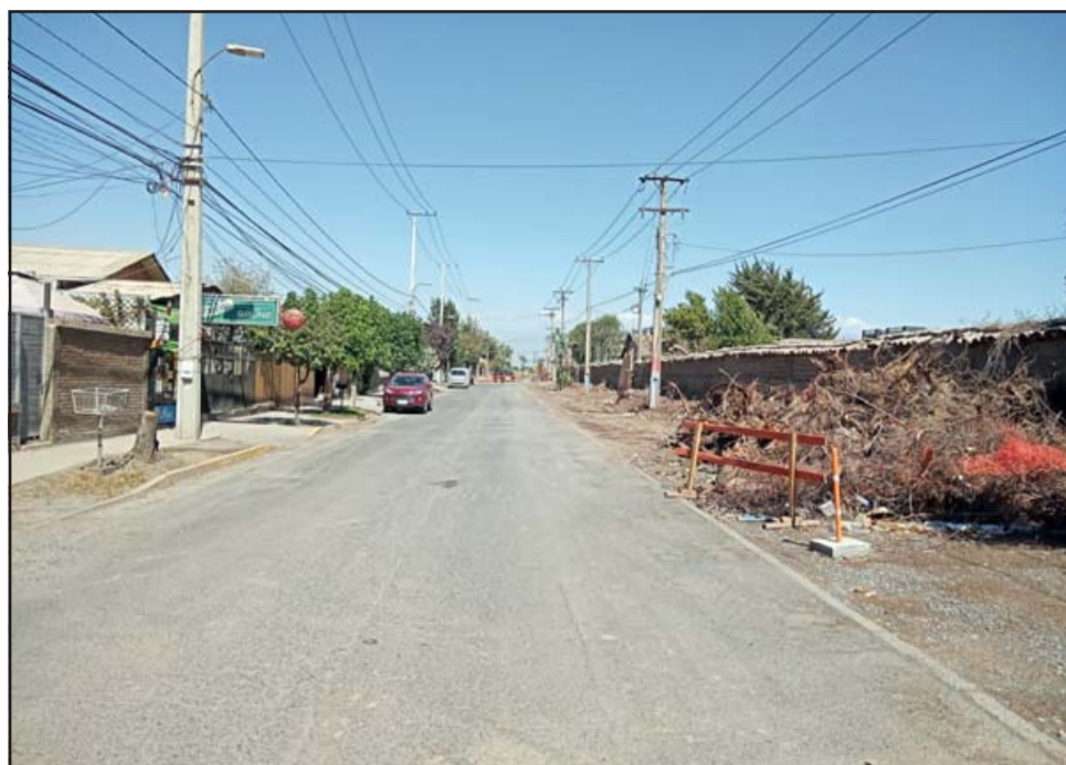
Avenida Michimalonco, donde vecinos reclaman que quedaron en una isla al haber cambiado la programación de los trabajos.
