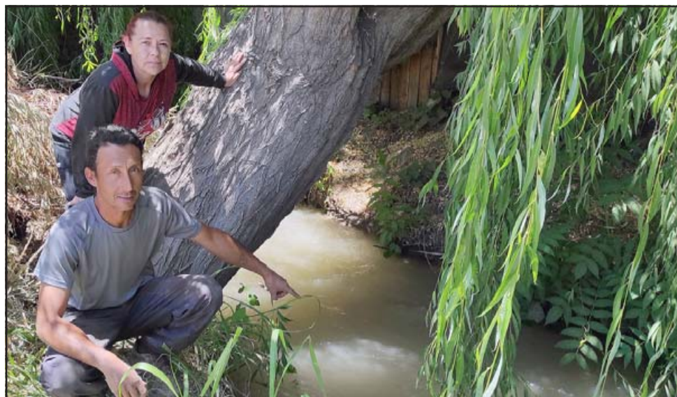
TEMIENDO LO PEOR.- Este canal de regadío minó las raíces del sauce, generando su caída parcial sobre la casa de estos vecinos.
