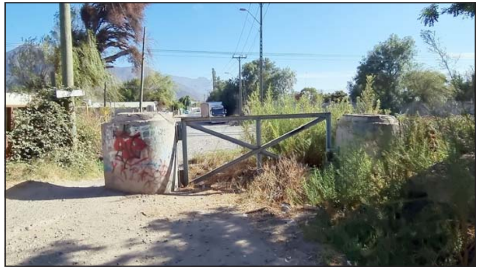
Este es el actual cierre que impide el paso a los vecinos e incluso a los organismos de emergencia, el cual deberá ser sacado.
