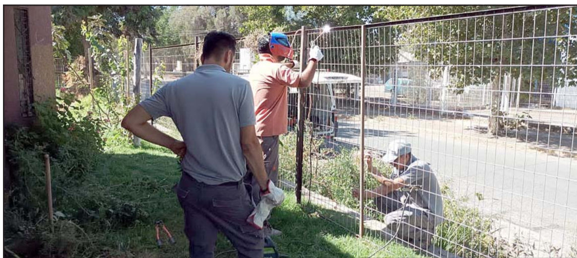
Acá se aprecia a personal de talleres municipales reponiendo la malla.
