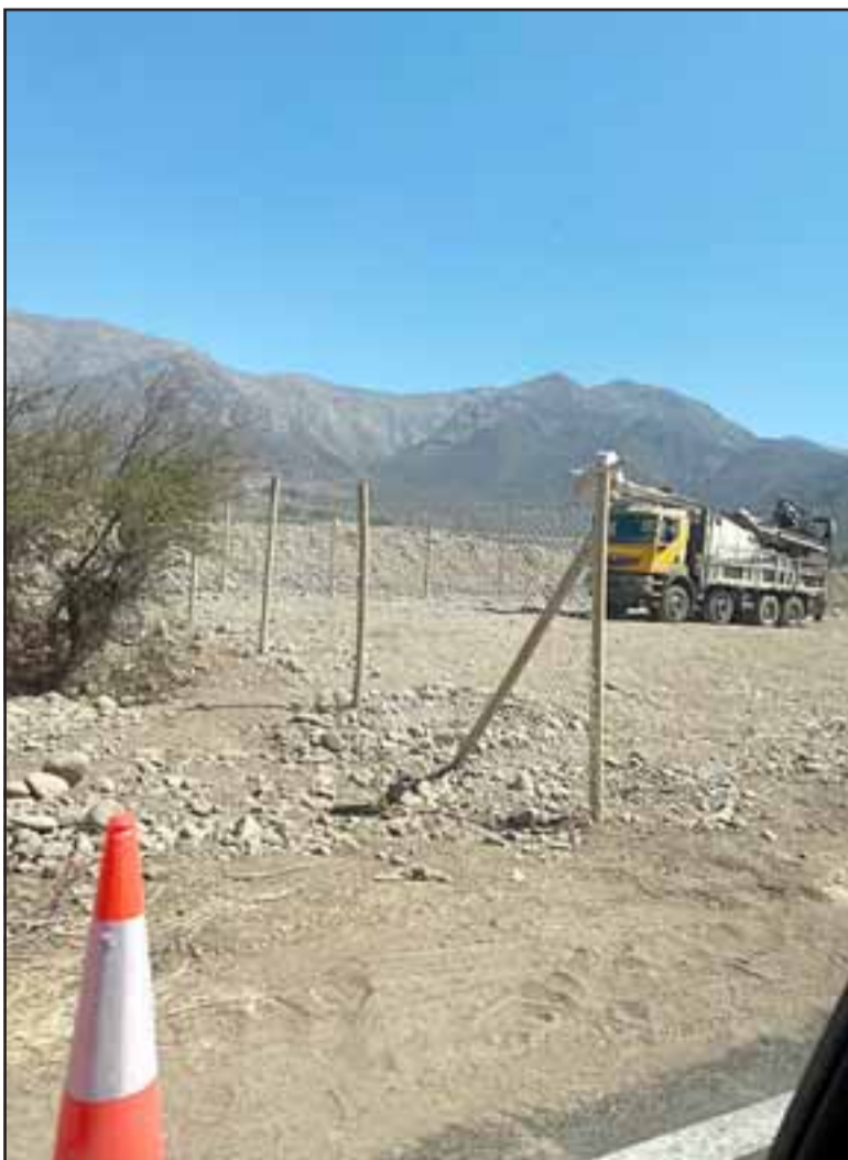
VECINOS EN ALERTA.- Frente a la comunidad ya se pueden ver máquinas de sondaje, ¿quién supervisa este proyecto?
