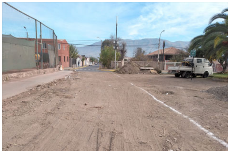
Comenzaron trabajos de construcción de calle Artemón Cifuentes, detrás del club de tenis.
