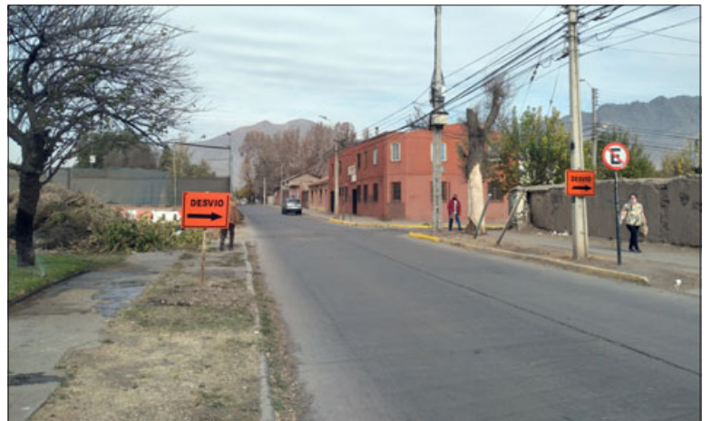
Desvío de tránsito en Yungay con Artemón Cifuentes, es el primero que se establece por las obras.
