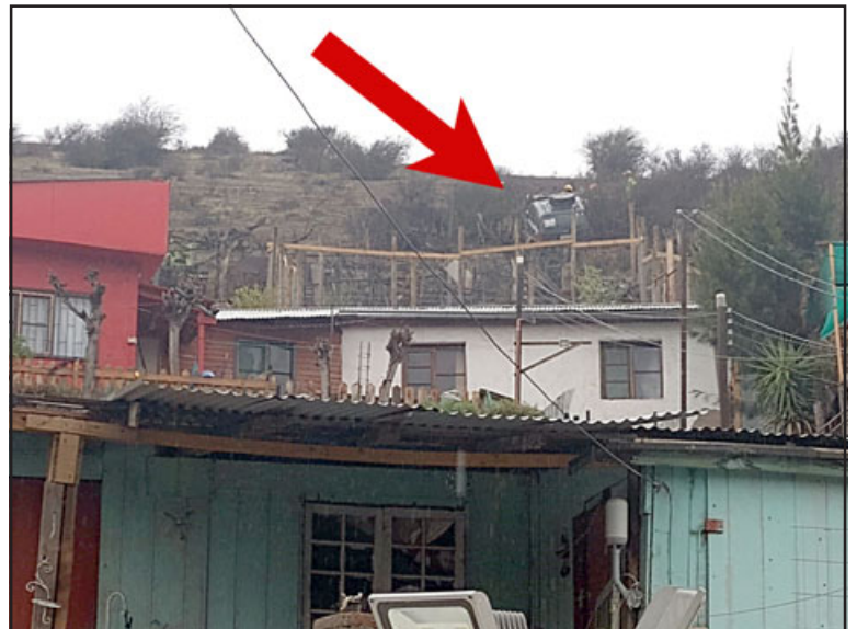
La flecha roja apunta al vehículo que amenaza con caer sobre las viviendas, con consecuencias que podrían ser fatales.
