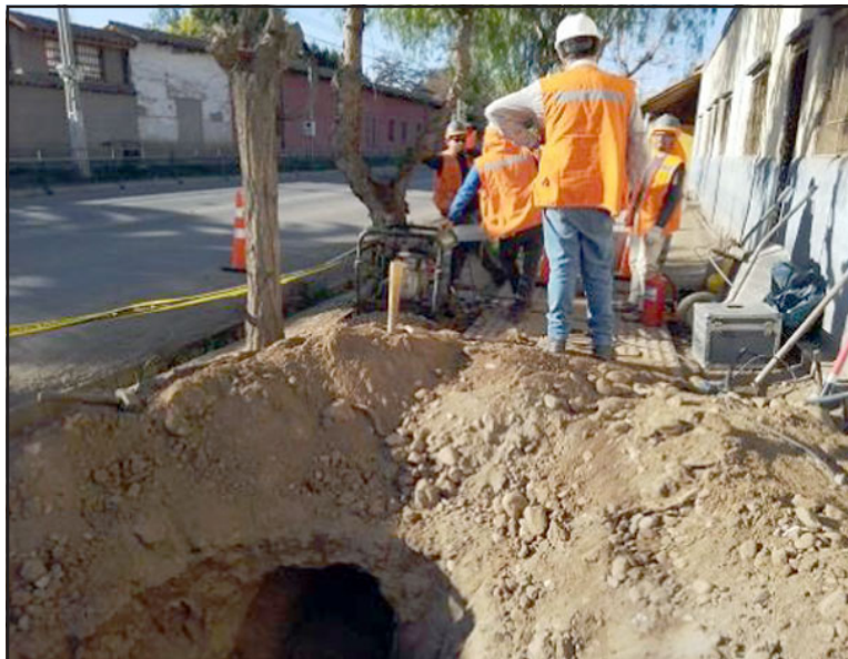
Entre las obras programadas, se encuentra la instalación de 139 metros de tuberías, reconexión de arranques domiciliarios, construcción de 13 cámaras válvulas y reposición de pavimentos.
