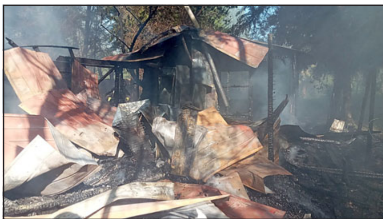
Lamentablemente la vivienda fue destruida por completo.
