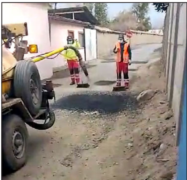
Trabajadores esparciendo asfalto sobre una calle en el sector El Asiento.
