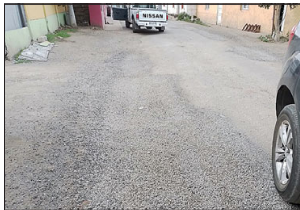
Calle Los Guindos, una de las que fueron sometidas a trabajos de mejoramiento.
