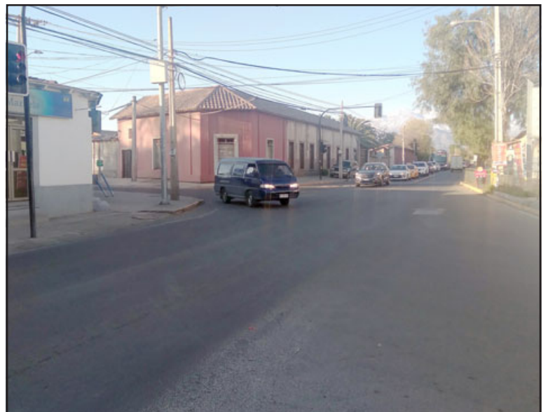
A partir de hoy lunes 26 se iniciará la instalación de atravesos en la ruta E-57 y calle La Pampilla, faenas que se extenderán por 14 días.
