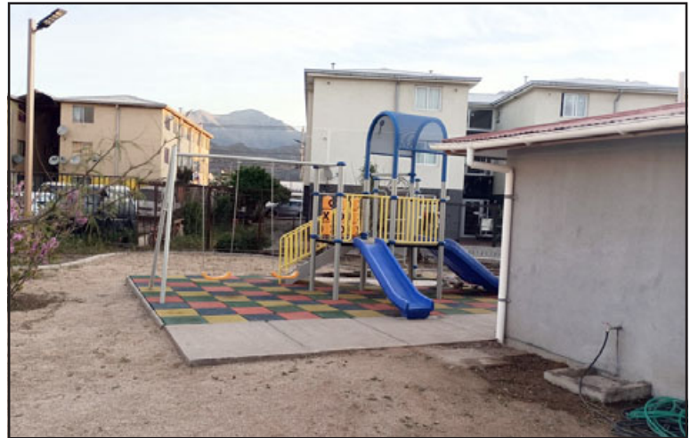
El proyecto también consideraba instalación de juegos para niños junto a la sede comunitaria.
