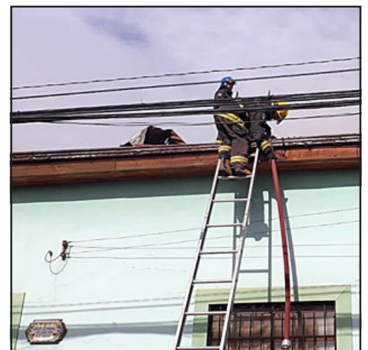
Bomberos trabajando en la sede de Junta de Vecinos Dominicanos, inmueble que también se vio afectado.
