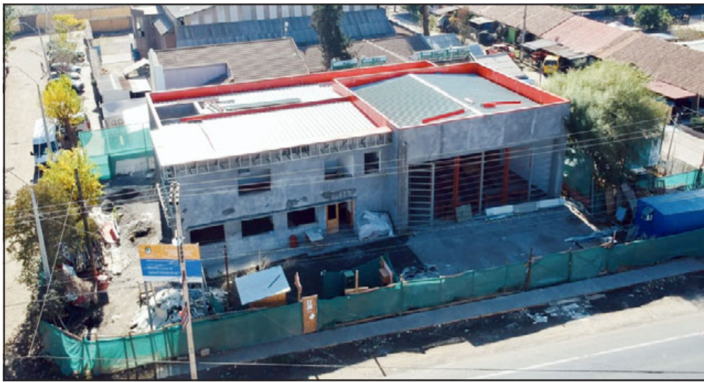
Las abandonadas obras del cuartel de Bomberos de Curimón se retomarán antes de fin de año.
