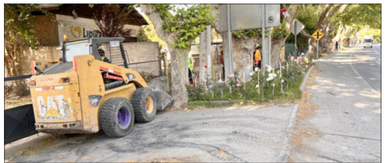
El proyecto consiste en la construcción de 1.750 metros lineales de aceras entre la Villa Colunquén y el Servicentro Shell de la comuna.
