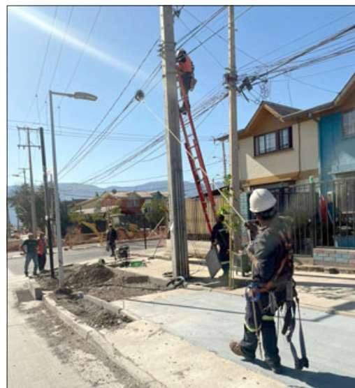
Chilquinta realizando trabajos de traslado de postes del tendido eléctrico.
