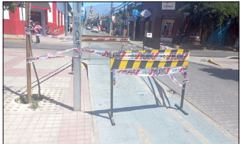
Comenzaron obras de reparación de ciclo vía en Prat con Toromazote.
