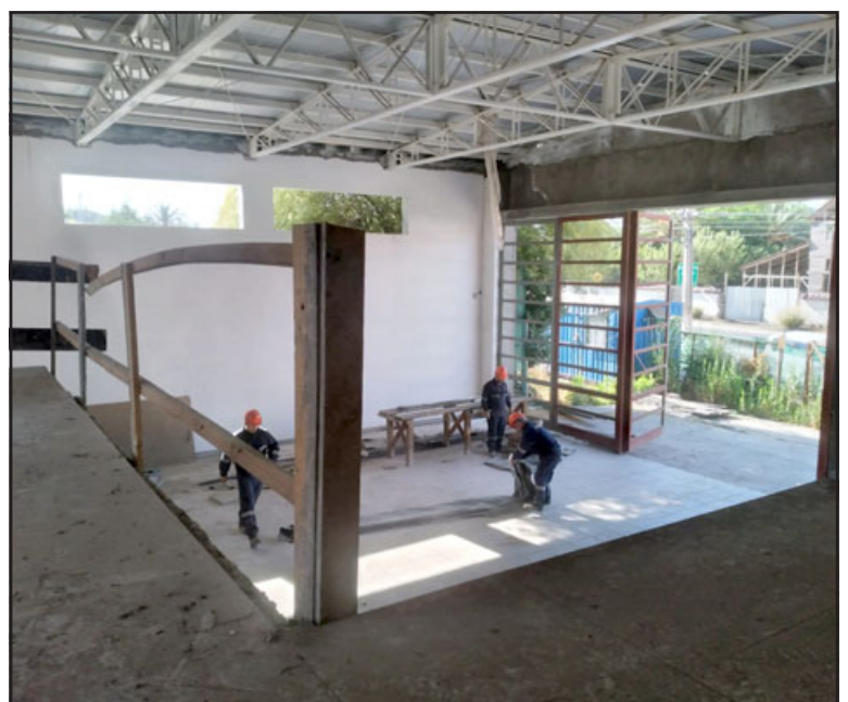
Vista desde el segundo piso de lo que será el nuevo cuartel.
