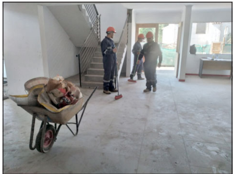
Retoman obras de construcción del cuartel de la Quinta Compañía de Bomberos de Curimón.
