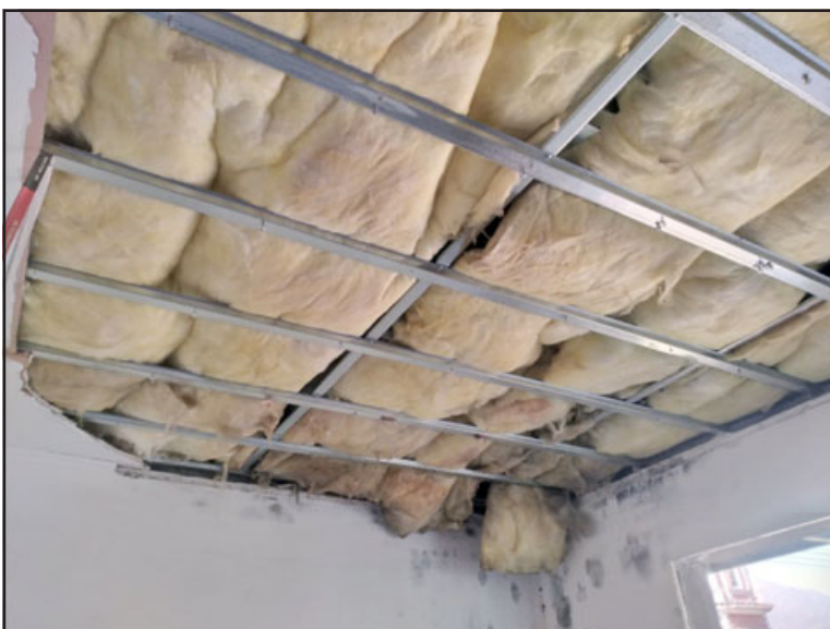
Así se encuentra parte del edificio que albergará a los bomberos.
