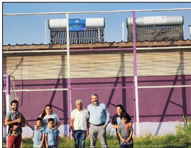
El termo solar ya instalado permite dotar de agua caliente los camarines y baños del club Olímpico de Putaendo.
