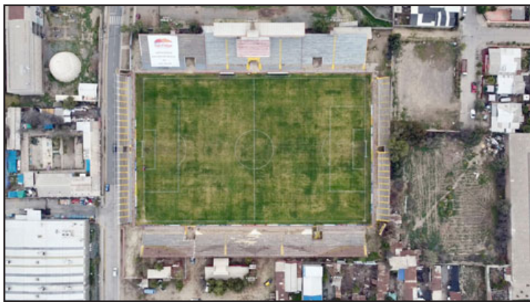
Los trabajos deberían estar concluidos en el mes de febrero de 2023.
