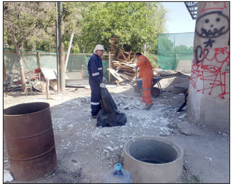
Trabajadores de la nueva empresa removiendo escombros para reiniciar la obra.
