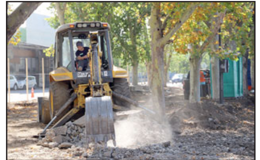
Más de 50 años tuvieron que pasar para que importante arteria de Los Andes recibiera millonaria intervención, solicitada por la comunidad.
