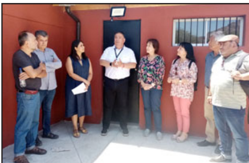
Uno de los grandes avances ha sido la reconstrucción de los camarines y baños.
