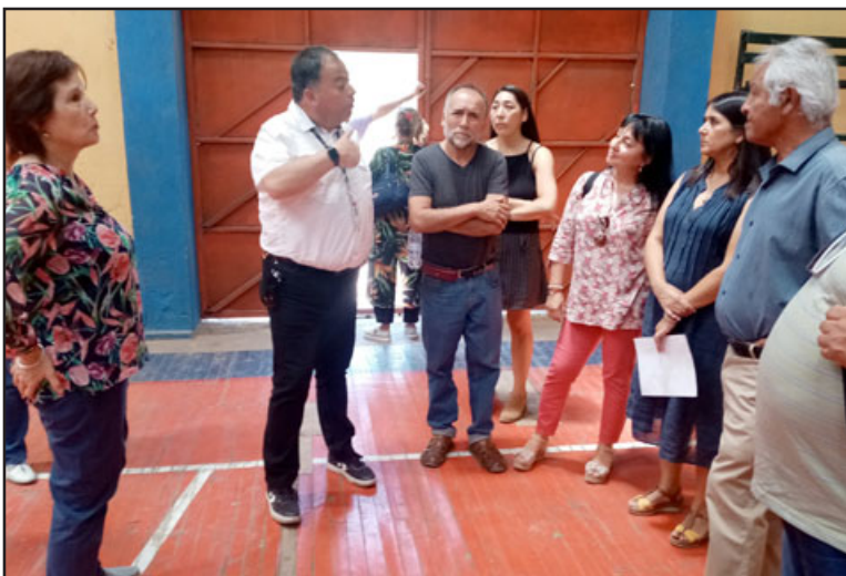
Las autoridades recorrieron los distintos puntos que han sido recuperados y los que faltan. La cancha del gimnasio tiene nueva luminaria, pero se debe cambiar el piso.
