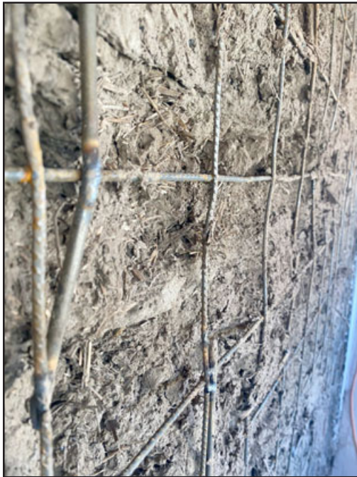
Estas con las mallas de acero que se instalan para reforzar la estructura.
