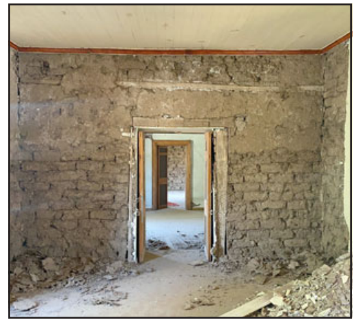
Así lucen actualmente las paredes del Mercado Dolores Otero de Putaendo.
