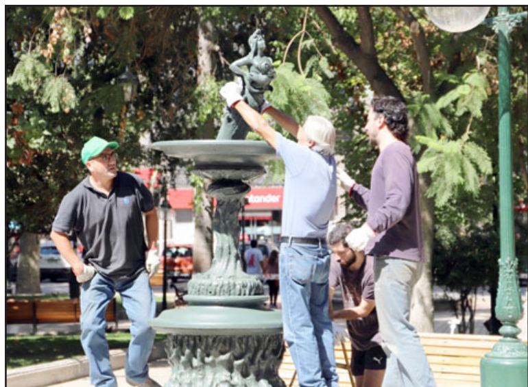
Ya fue instalada la pileta de la Plaza de Armas de Los Andes, luego de un año de trabajos debido a su intenso deterioro.
