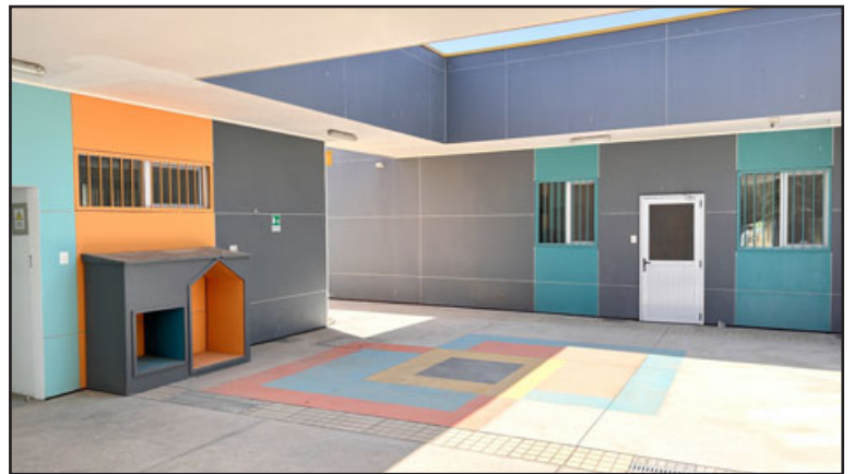
La obra demandó una inversión de casi 431 millones de pesos, siendo financiada íntegramente con recursos Junji en un terreno aportado por la Municipalidad de Panquehue.
