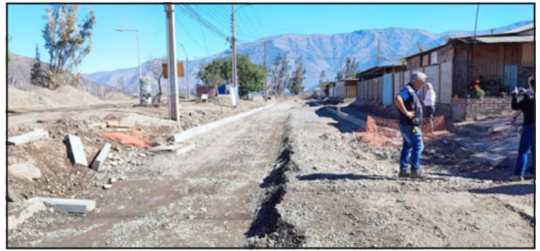
Los trabajos presentan cerca de un 44% de avance y se encuentran dentro de los plazos estipulados en contrato.
