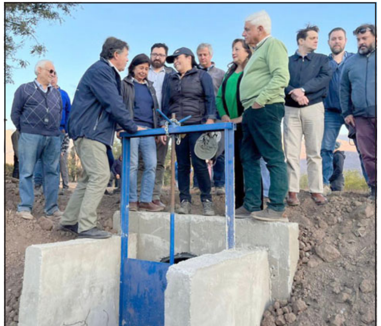
El ministro de Agricultura Esteban Valenzuela, encabezó la inspección de una obra de mejoramiento del canal Rinconada, proyecto que permitirá llegar con el recurso hídrico hasta el tramo final del canal.
