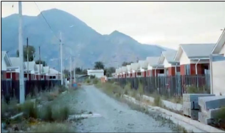
La construcción de viviendas del comité 'Los Nogales 1' de Catemu estuvo paralizada desde el mes de febrero del año pasado. (Foto archivo)
