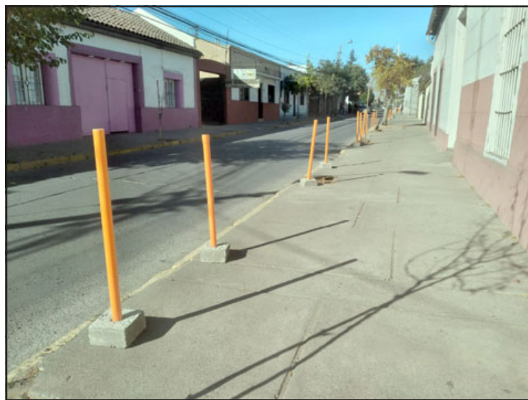
Trabajos de mejoramiento de veredas en calle Santo Domingo realizará el municipio.
