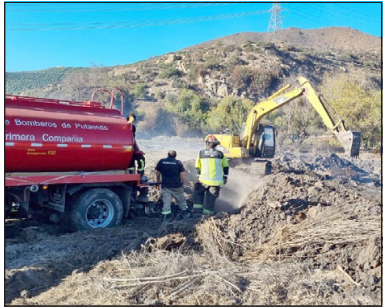
Con maquinaria pesada se debió trabajar para apagar incendio de pastizales en Llay Llay.
