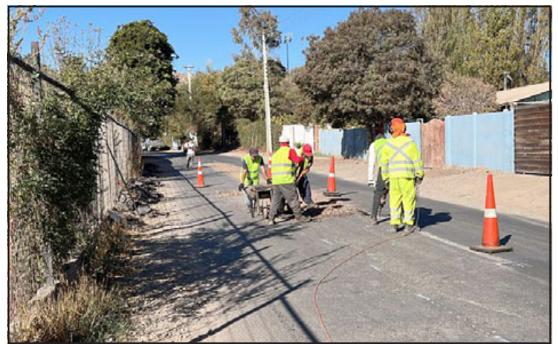
Paleteros instalados durante trabajos del sector.
