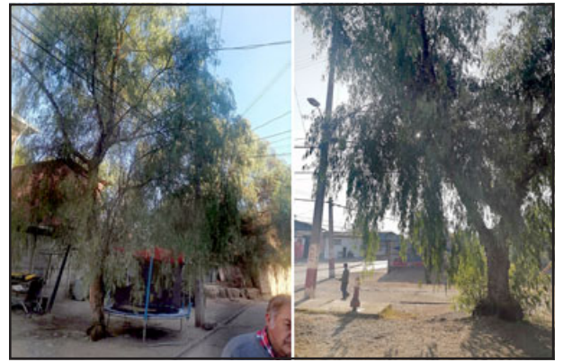
Primer árbol que interfiere con el cableado eléctrico, ubicado detrás del Block A. Segundo árbol que interfiere con los cables, ubicado en frente del Block A.
