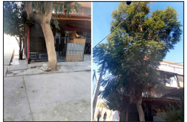
El tercer árbol interfiere con el alcantarillado, ubicado a un costado del Block 10. El tercer árbol también interfiere con el cableado eléctrico.
