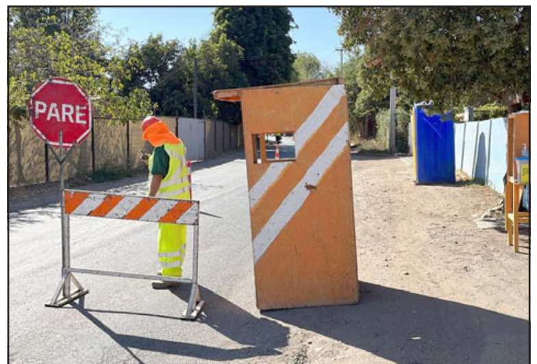
Segregación de zona de trabajos, a cargo de paleteros y conos.
