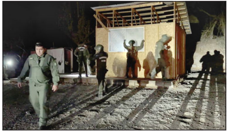
Esta es la mediagua levantada en el terreno fiscal, sobre un sólido radier de cemento.
