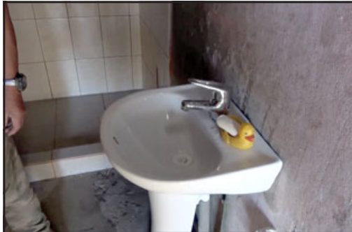
Instalación de lavamanos.
