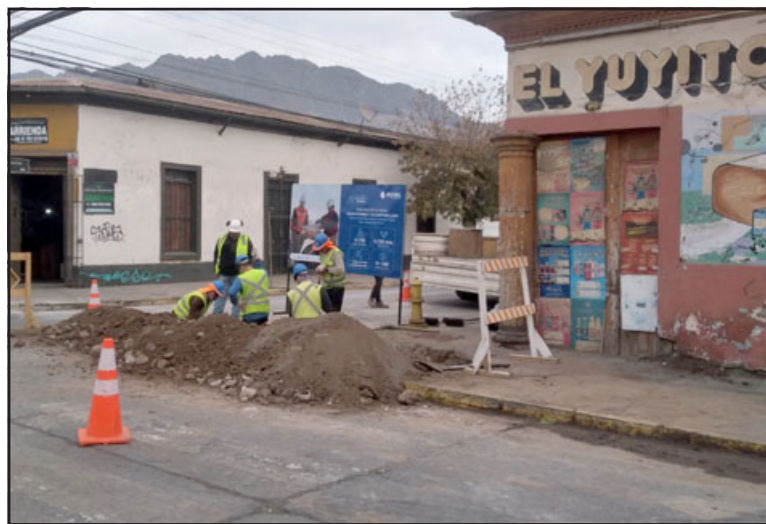
Trabajos en Navarro esquina San Martín.
