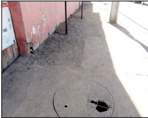
Así se ve calle Navarro con los trabajos que se han realizado en las veredas.
