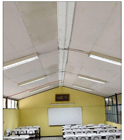
La lluvia generó goteras en el establecimiento, específicamente en el comedor, donde se puede apreciar las manchas en el cielo del salón.
