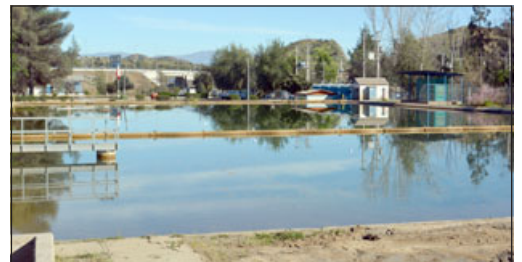
Sanitaria trabaja desde enero en proyecto que permitirá sumar progresivamente más horas de respaldo: 18 horas a fines de 2023 y 48 horas el 2024.
