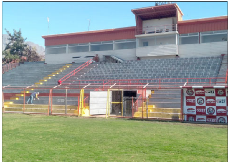
Así se ejecutan los trabajos de mejoramiento en el estadio municipal.
