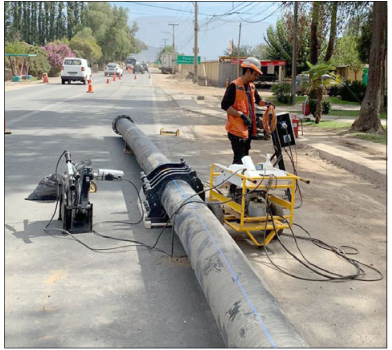
A la fecha, sólo resta la instalación del último tramo de tuberías, estimándose el término de las obras para fines de este mes.
