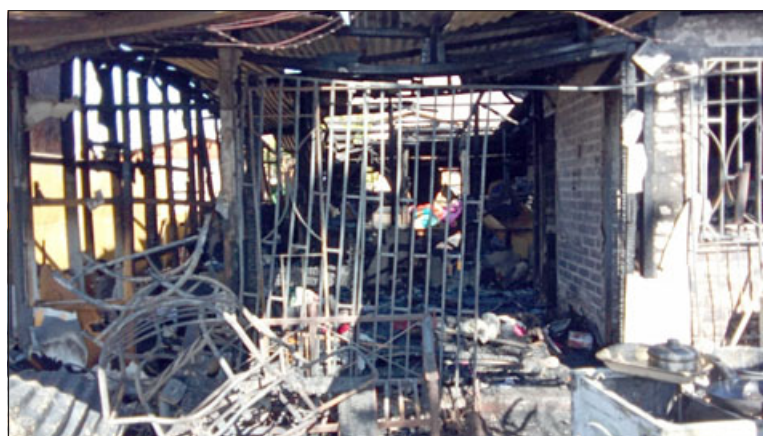
Lamentablemente, otras dos viviendas resultaron completamente dañadas.
